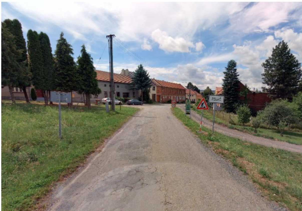
Obrázek 4: Ukázka stavu silnice 43310 na okraji obce
